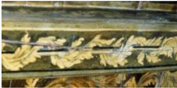
Mengstr. 50, Diele, Balkendecke
