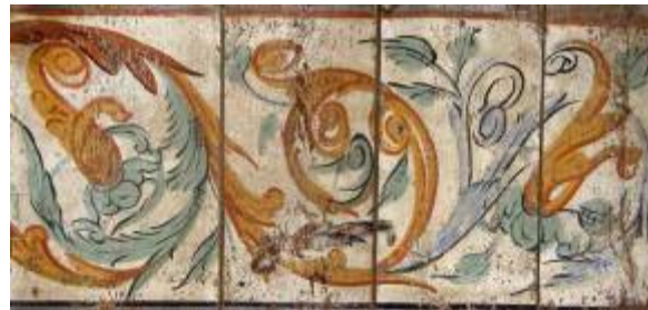
Wismar, Mecklenburger Str. 12, Balkendecke, 1640/50 (Denkmalpflege Mecklenburg-Vorpommern)
