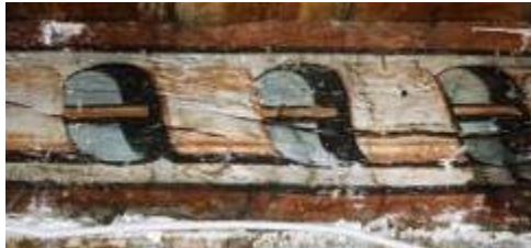
Hundestr. 62, Seitenflügel, Deckenbalken kurz nach 1659
