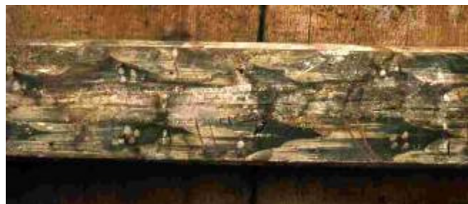
Engelsgrube 23, Seitenflügel, zwischen 1610 und 1650
