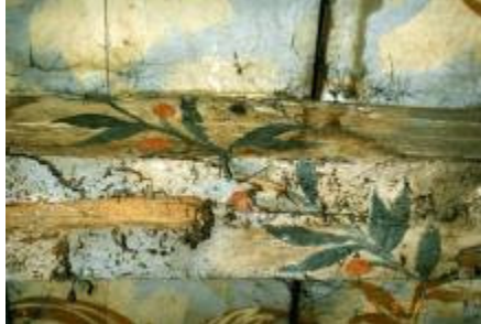
An der Untertrave 52, Deckenbalken 1710-40
