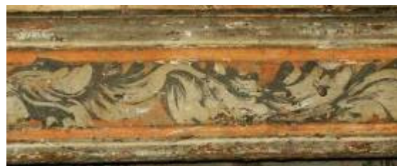
Glockengießerstr. 26, Seitenflügel, Balkendecke
