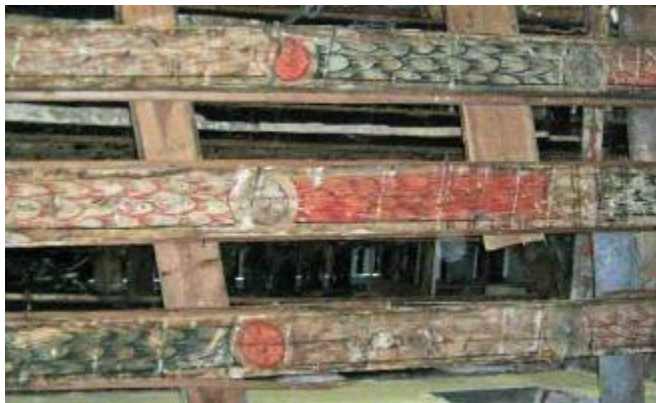
Thorn/Torun, Breite Str. 19/Ul. Szeroka 19, Balkendecke
