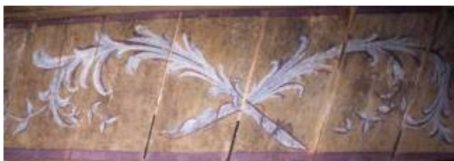
An der Obertrave 42, Diele, Balkendecke
