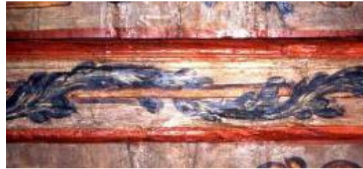
Mengstr. 23, Diele, Balkendecke
