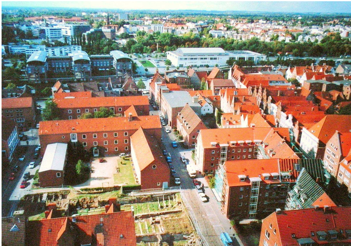
Blick von St. Marien Richtung Westen/Trave; rechts Mengstraße, in der Mitte Alfstraße, links die Braunstraße; in Fisch- und Alfstraße dominiert moderner Baubestand der 1950er und 1960er Jahre.
